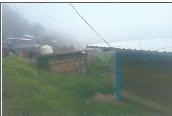
Foto 4: predios en construcción
