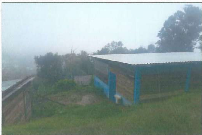
Foto 3: predios en construcción
